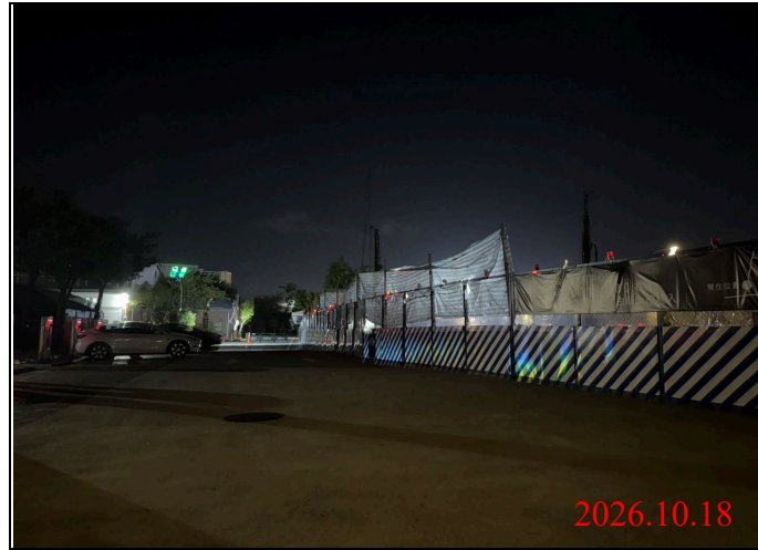
巡查日期地點：115.10.18/ Y34車站 照片說明：夜間路面、路燈及警示燈狀況
