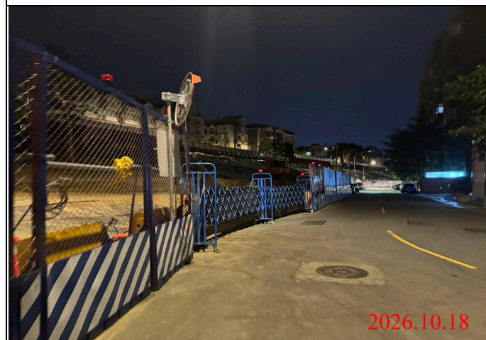
巡查日期地點：115.10.18/ Y33車站 照片說明：夜間路面、路燈及警示燈狀況
