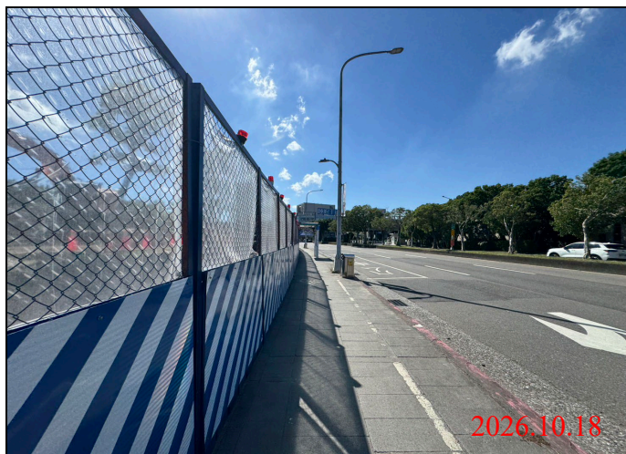
巡查日期地點：115.10.18/ Y34車站 照片說明：路面狀況
