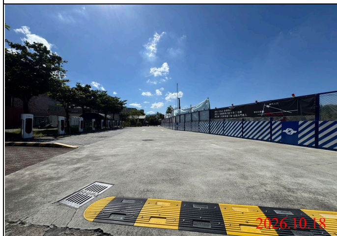
巡查日期地點：115.10.18/ Y34車站 照片說明：路面狀況
