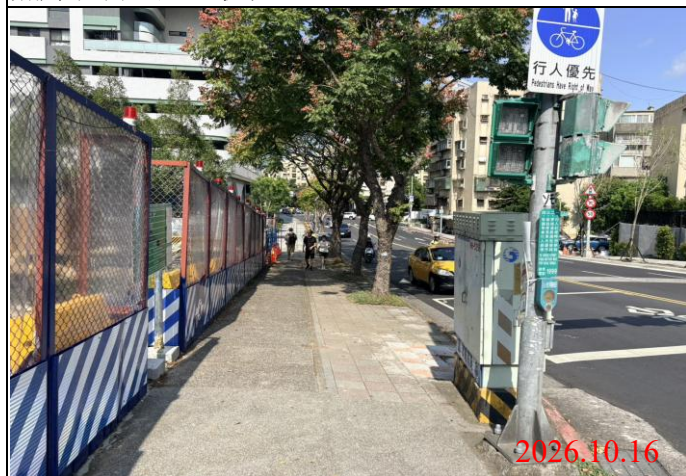
巡查日期地點：115.10.16/ Y33車站 照片說明：路面狀況
