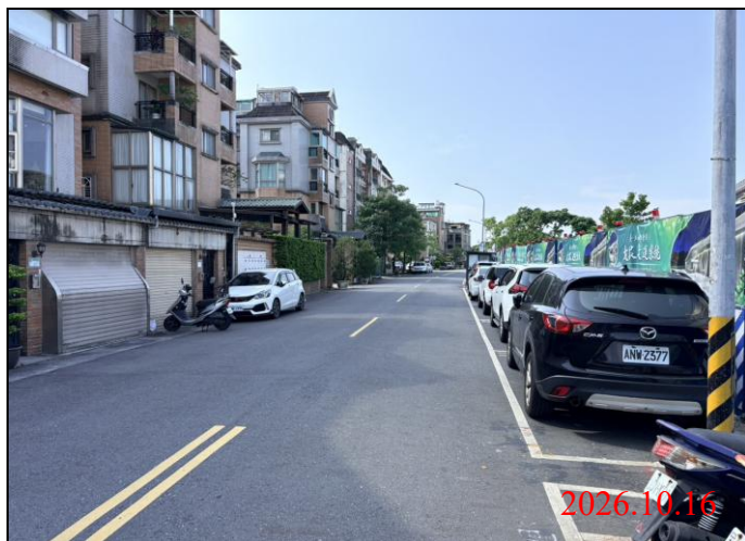
巡查日期地點：115.10.16/ Y33車站 照片說明：路面狀況
