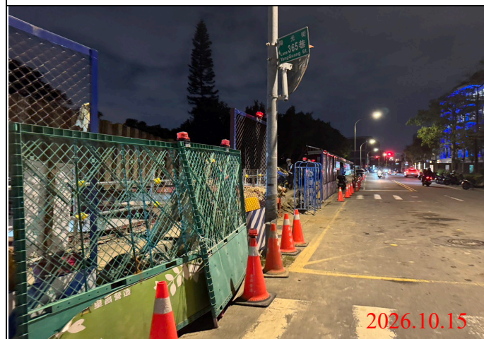
巡查日期地點：115.10.15/ Y33車站 照片說明：夜間路面、路燈及警示燈狀況
