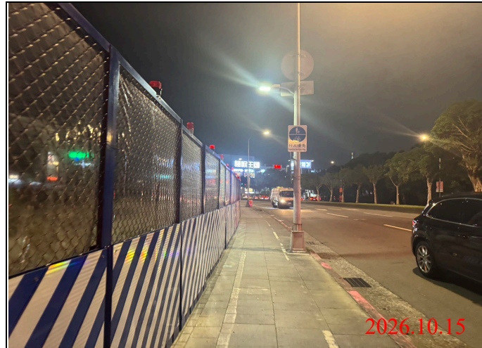
巡查日期地點：115.10.15/ Y34車站 照片說明：夜間路面、路燈及警示燈狀況
