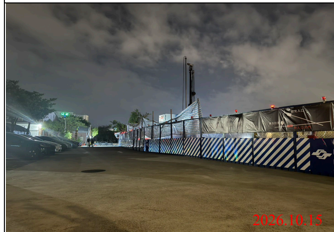
巡查日期地點：115.10.15/ Y34車站 照片說明：夜間路面、路燈及警示燈狀況
