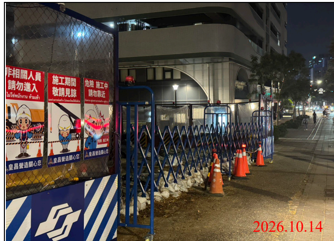
巡查日期地點：115.10.14/ Y33車站 照片說明：出入口大門確實關閉上鎖
