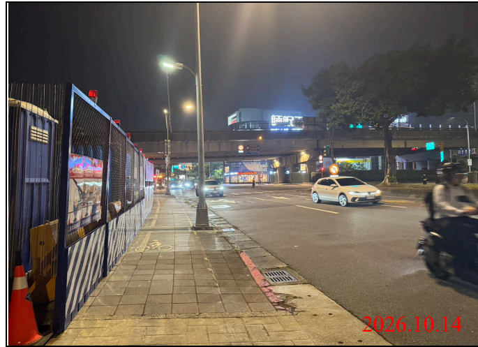
巡查日期地點：115.10.14/ Y34車站 照片說明：夜間路面、路燈及警示燈狀況
