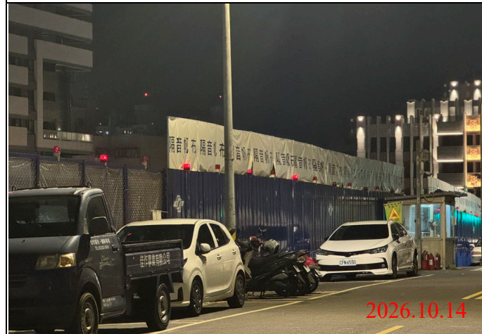
巡查日期地點：115.10.14/ Y33車站 照片說明：夜間路面、路燈及警示燈狀況
