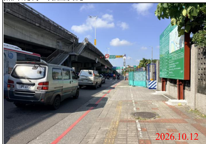
巡查日期地點：115.10.12/ Y34車站 照片說明：路面狀況
