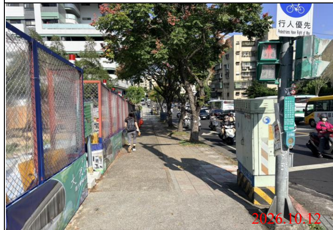
巡查日期地點：115.10.12/ Y33車站 照片說明：路面狀況
