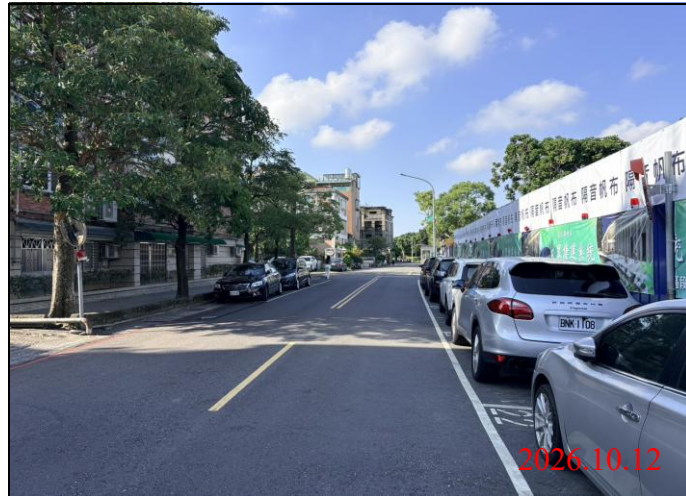
巡查日期地點：115.10.12/ Y33車站 照片說明：路面狀況
