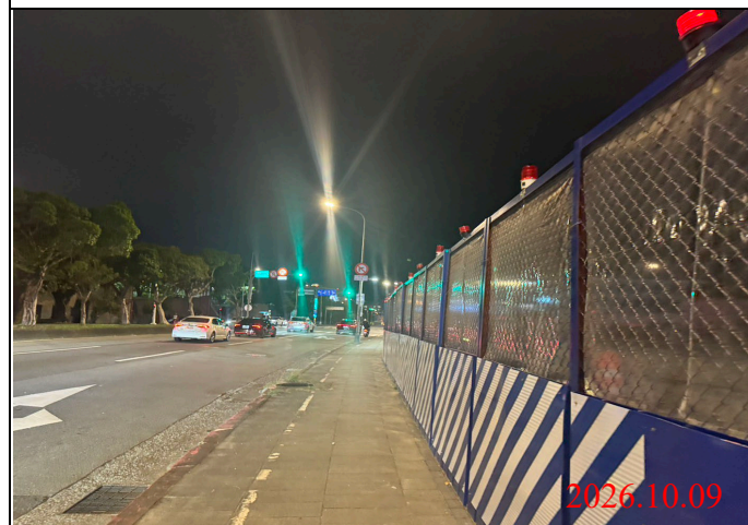
巡查日期地點：115.10.09/ Y34車站 照片說明：夜間路面、路燈及警示燈狀況
