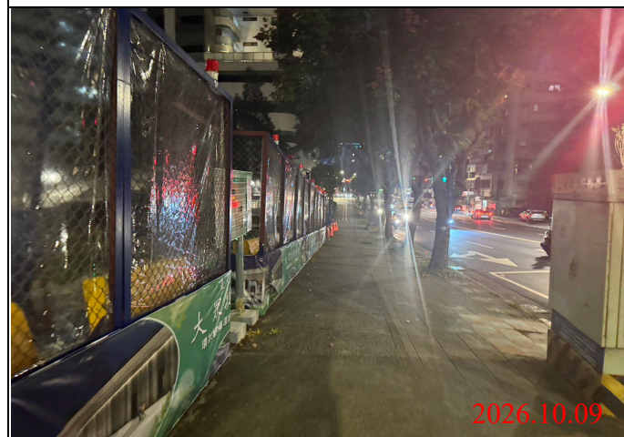
巡查日期地點：115.10.09/ Y33車站 照片說明：夜間路面、路燈及警示燈狀況
