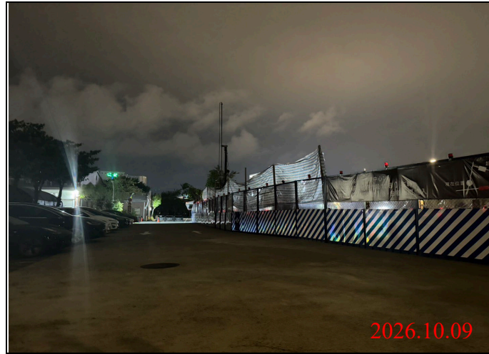
巡查日期地點：115.10.09/ Y34車站 照片說明：夜間路面、路燈及警示燈狀況
