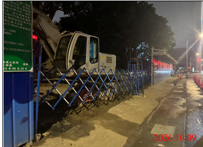
巡查日期地點：115.10.09/ Y33車站 照片說明：出入口大門確實關閉上鎖
