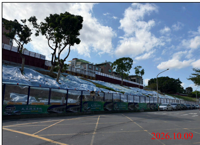
巡查日期地點：115.10.09/ Y33車站 照片說明：路面狀況
