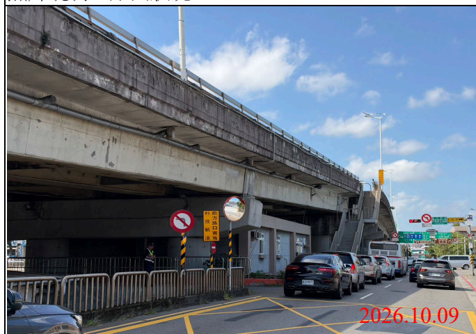
巡查日期地點：115.10.09/ Y34車站 照片說明：路面狀況
