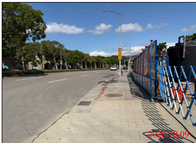
巡查日期地點：115.10.09/ Y34車站 照片說明：路面狀況
