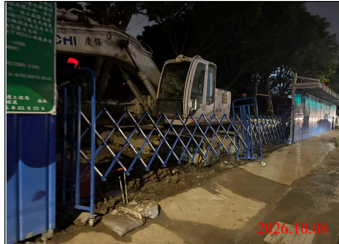
巡查日期地點：115.10.08/ Y33車站 照片說明：出入口大門確實關閉上鎖
