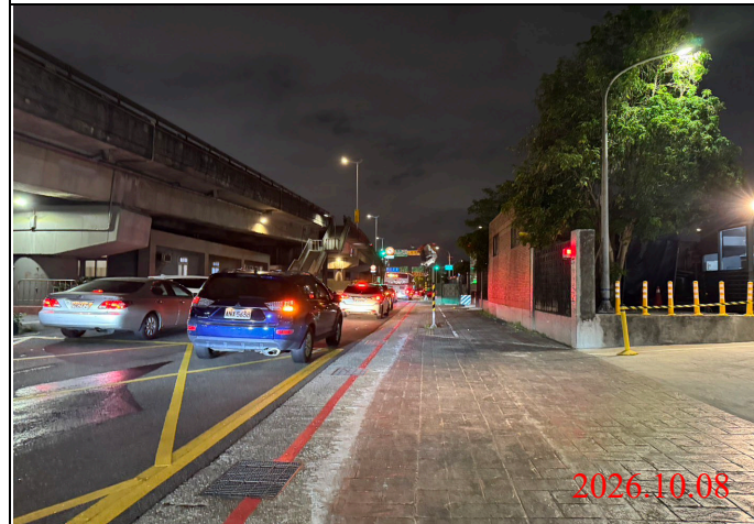
巡查日期地點：115.10.08/ Y34車站 照片說明：夜間路面、路燈及警示燈狀況
