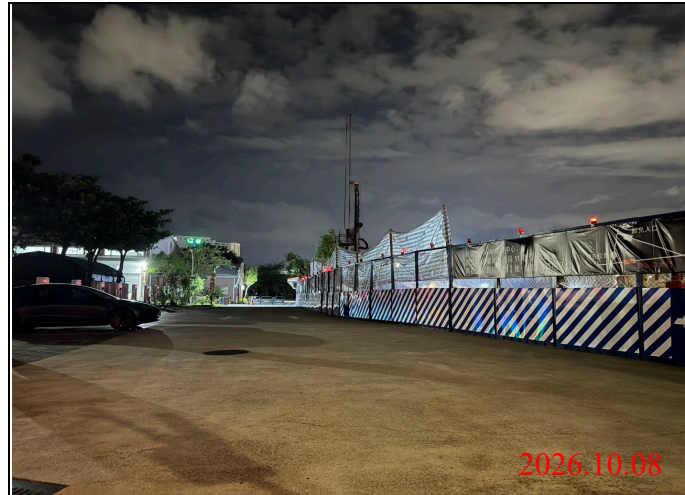
巡查日期地點：115.10.08/ Y34車站 照片說明：夜間路面、路燈及警示燈狀況
