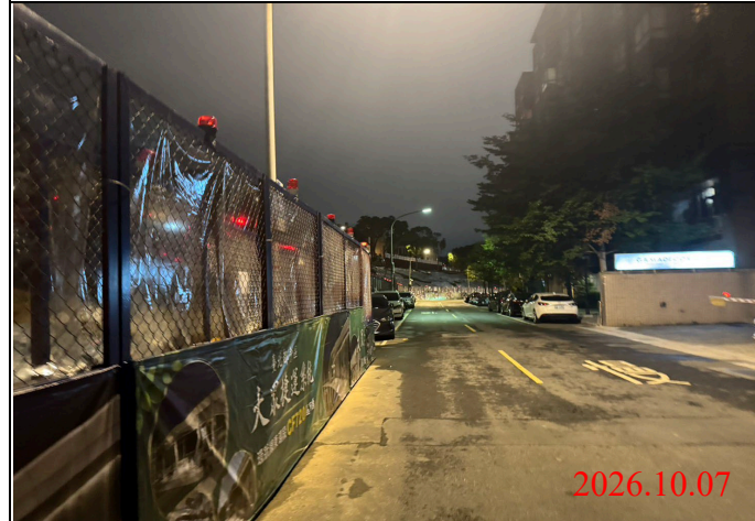
巡查日期地點：115.10.07/ Y33車站 照片說明：夜間路面、路燈及警示燈狀況
