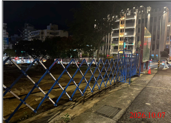
巡查日期地點：115.10.07/ Y33車站 照片說明：出入口大門確實關閉上鎖
