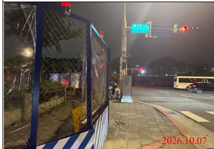
巡查日期地點：115.10.07/ Y34車站 照片說明：夜間路面、路燈及警示燈狀況
