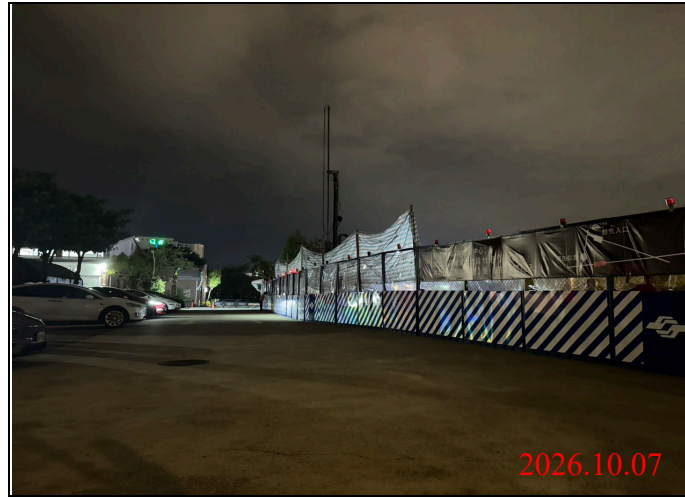
巡查日期地點：115.10.07/ Y34車站 照片說明：夜間路面、路燈及警示燈狀況
