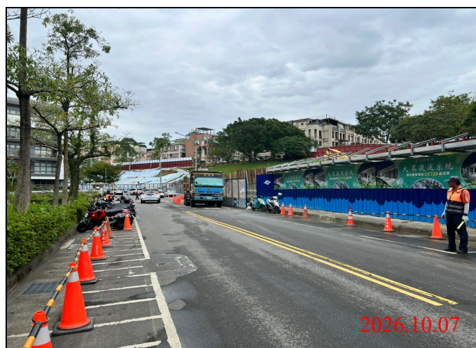
巡查日期地點：115.10.07/ Y33車站 照片說明：路面狀況
