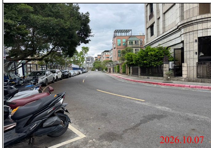
巡查日期地點：115.10.07/ Y33車站 照片說明：路面狀況
