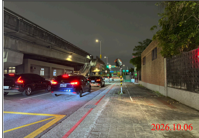
巡查日期地點：115.10.06/ Y34車站 照片說明：夜間路面、路燈及警示燈狀況
