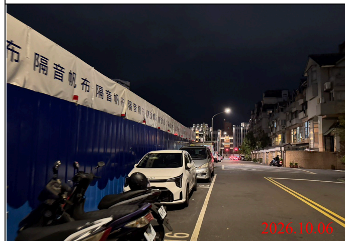
巡查日期地點：115.10.06/ Y33車站 照片說明：夜間路面、路燈及警示燈狀況
