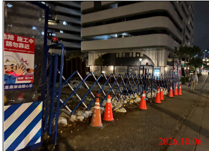
巡查日期地點：115.10.06/ Y33車站 照片說明：出入口大門確實關閉上鎖
