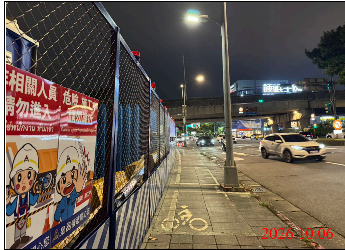
巡查日期地點：115.10.06/ Y34車站 照片說明：夜間路面、路燈及警示燈狀況
