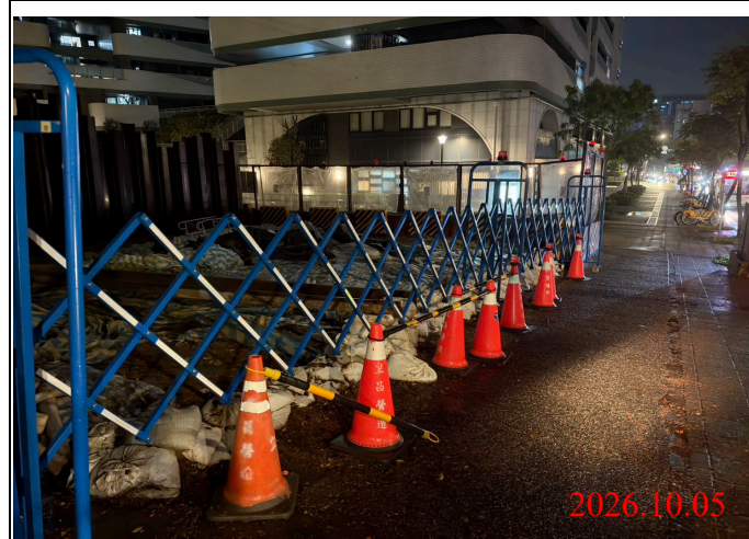
巡查日期地點：115.10.05/ Y33車站 照片說明：出入口大門確實關閉上鎖
