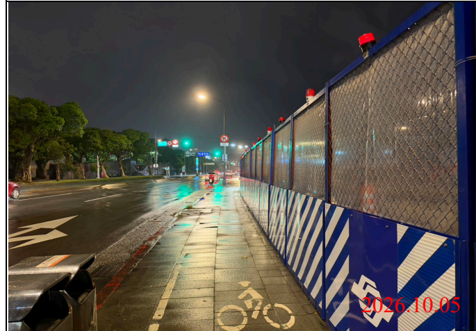
巡查日期地點：115.10.05/ Y34車站 照片說明：夜間路面、路燈及警示燈狀況
