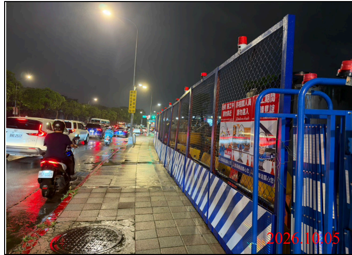
巡查日期地點：115.10.05/ Y34車站 照片說明：夜間路面、路燈及警示燈狀況
