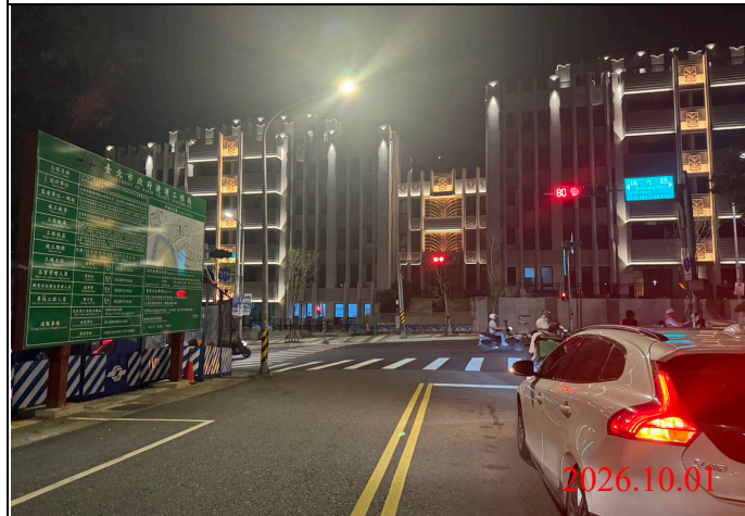
巡查日期地點：115.10.01/ Y33車站 照片說明：夜間路面、路燈及警示燈狀況
