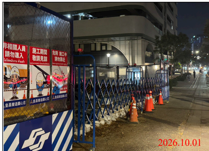
巡查日期地點：115.10.01/ Y33車站 照片說明：出入口大門確實關閉上鎖
