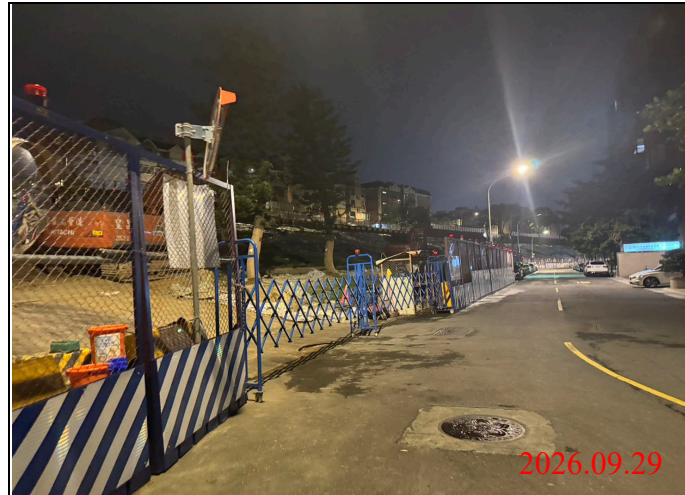
巡查日期地點：115.09.29/ Y33車站 照片說明：出入口大門確實關閉上鎖
