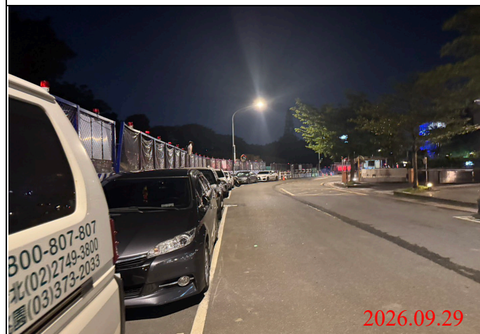
巡查日期地點：115.09.29/ Y33車站 照片說明：夜間路面、路燈及警示燈狀況
