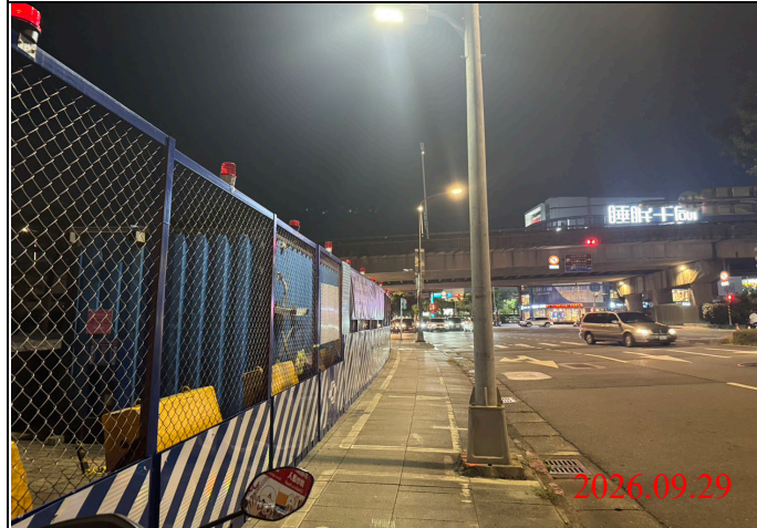
巡查日期地點：115.09.29/ Y34車站 照片說明：夜間路面、路燈及警示燈狀況
