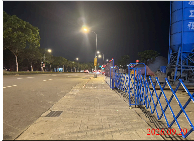
巡查日期地點：115.09.29/ Y34車站 照片說明：出入口大門確實關閉上鎖
