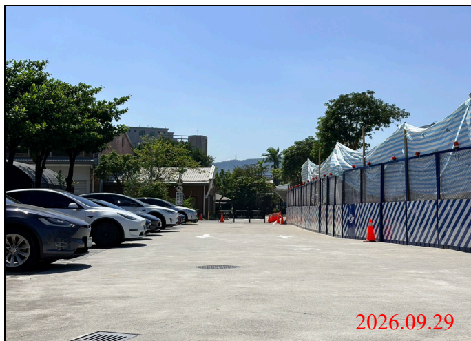
巡查日期地點：115.09.29/ Y34車站 照片說明：路面狀況
