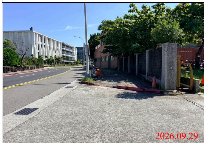
巡查日期地點：115.09.29/ Y34車站 照片說明：路面狀況
