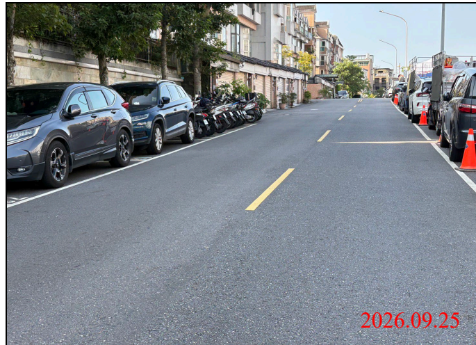
巡查日期地點：115.09.25/ Y33車站 照片說明：路面狀況
