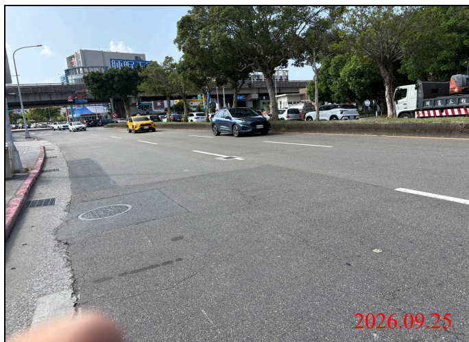
巡查日期地點：115.09.25/ Y34車站 照片說明：路面狀況
