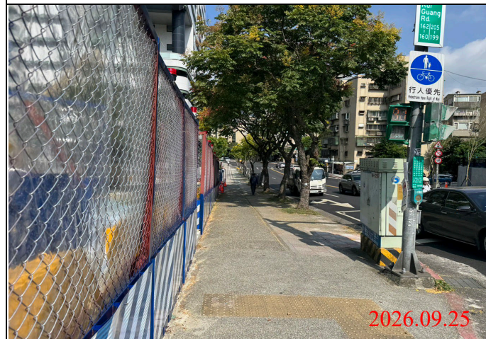
巡查日期地點：115.09.25/ Y33車站 照片說明：路面狀況
