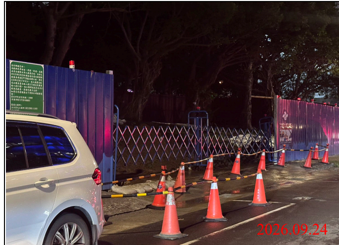
巡查日期地點：115.09.24/ Y33車站 照片說明：出入口大門確實關閉上鎖
