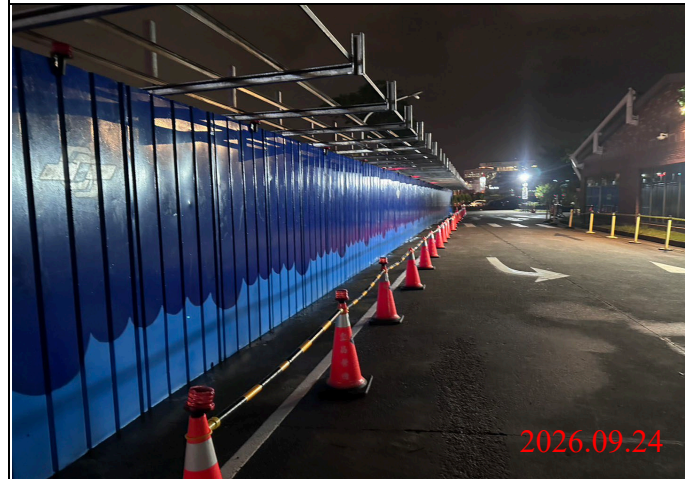
巡查日期地點：115.09.24/ Y34車站 照片說明：夜間路面、路燈及警示燈狀況
