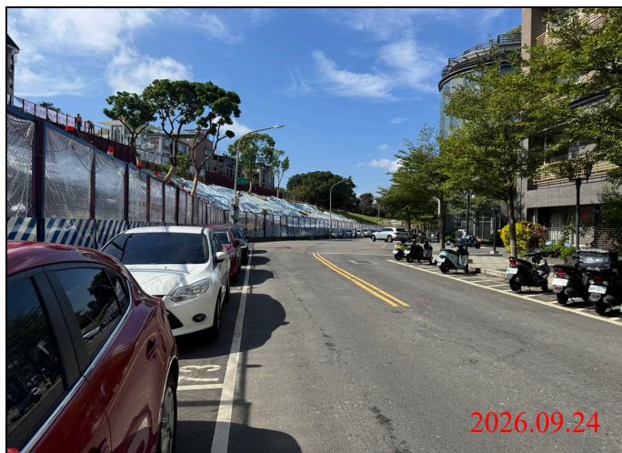
巡查日期地點：115.09.24/ Y33車站 照片說明：路面狀況
