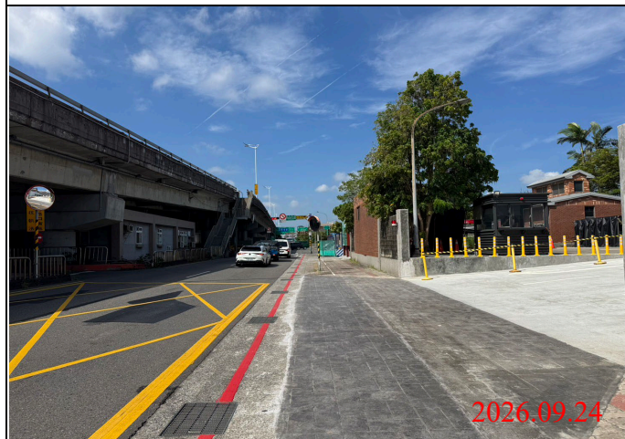
巡查日期地點：115.09.24/ Y34車站 照片說明：路面狀況
