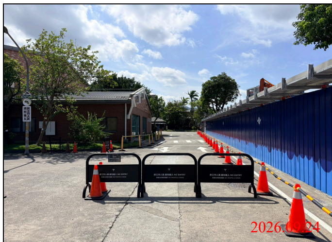
巡查日期地點：115.09.24/ Y34車站 照片說明：路面狀況
