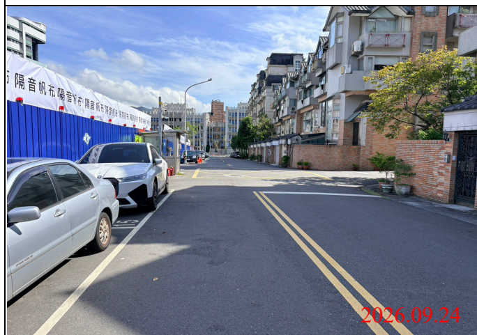
巡查日期地點：115.09.24/ Y33車站 照片說明：路面狀況
