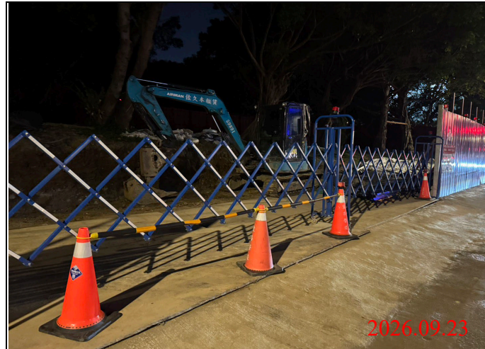
巡查日期地點：115.09.23/ Y33車站 照片說明：出入口大門確實關閉上鎖
