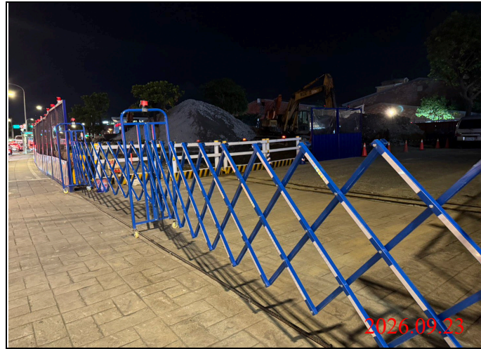
巡查日期地點：115.09.23/ Y34車站 照片說明：出入口大門確實關閉上鎖
