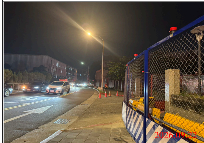
巡查日期地點：115.09.22/ Y34車站 照片說明：夜間路面、路燈及警示燈狀況
