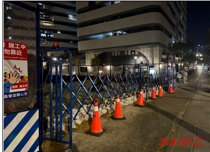
巡查日期地點：115.09.22/ Y33車站 照片說明：出入口大門確實關閉上鎖
