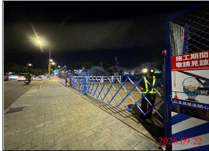
巡查日期地點：115.09.22/ Y34車站 照片說明：出入口大門確實關閉上鎖
