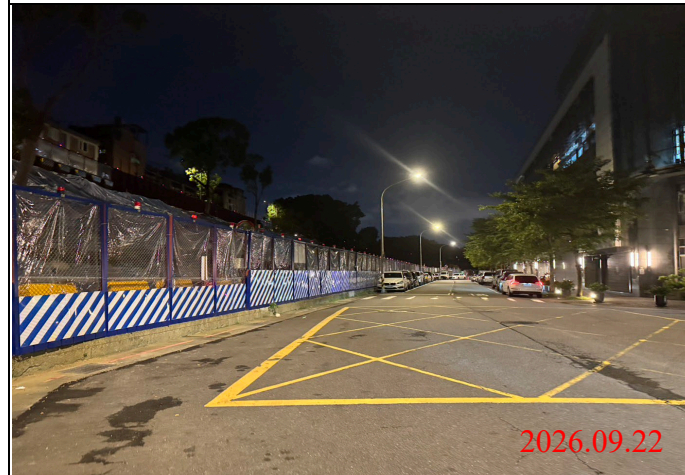
巡查日期地點：115.09.22/ Y33車站 照片說明：夜間路面、路燈及警示燈狀況
