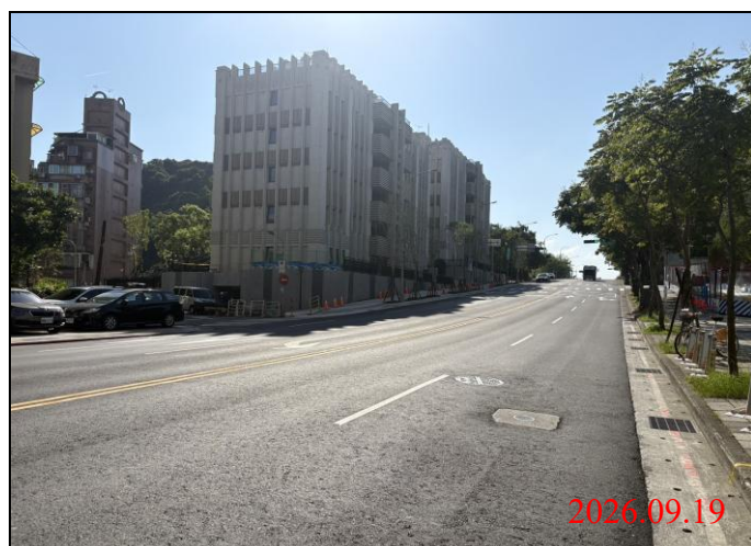
巡查日期地點：115.09.19/ Y33車站 照片說明：路面狀況
