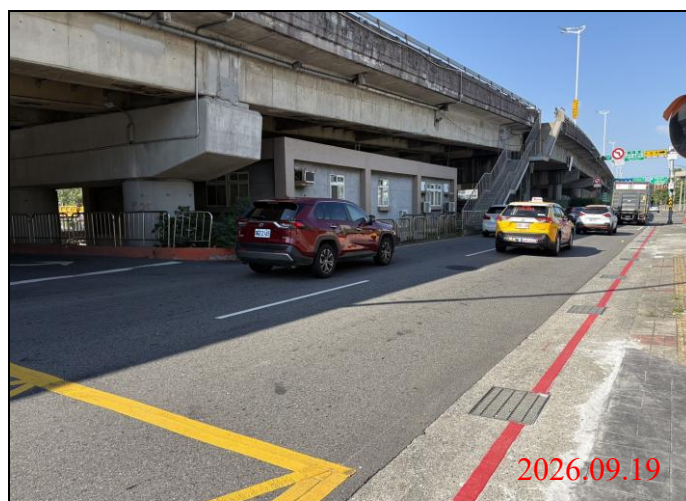
巡查日期地點：115.09.19/ Y34車站 照片說明：路面狀況
