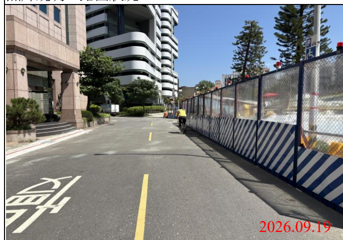
巡查日期地點：115.09.19/ Y33車站 照片說明：路面狀況
