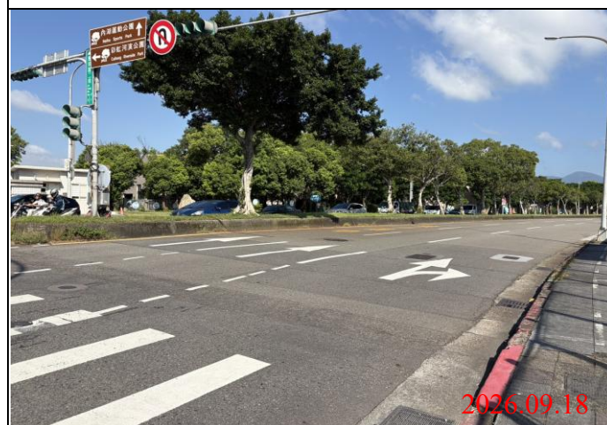
巡查日期地點：115.09.19/ Y34車站 照片說明：路面狀況
