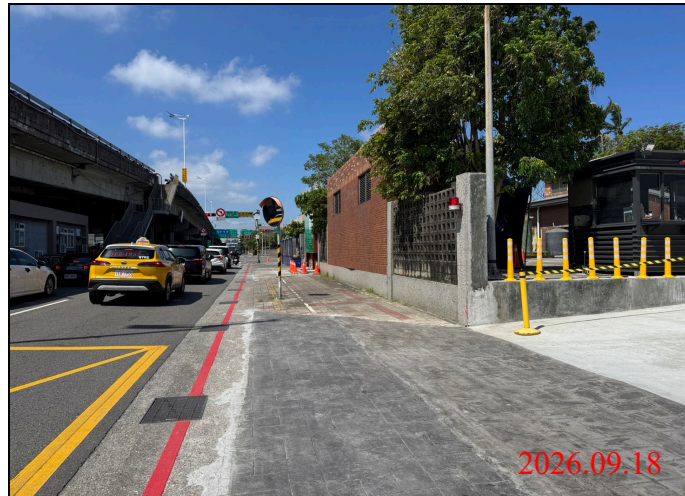
巡查日期地點：115.09.18/ Y34車站 照片說明：路面狀況
