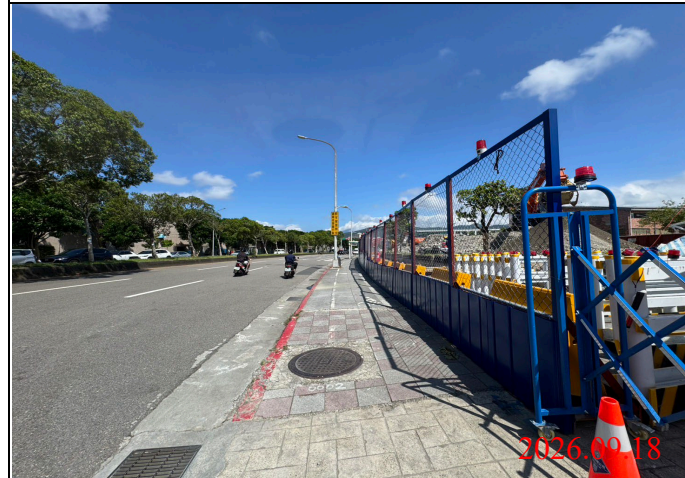
巡查日期地點：115.09.18/ Y34車站 照片說明：路面狀況
