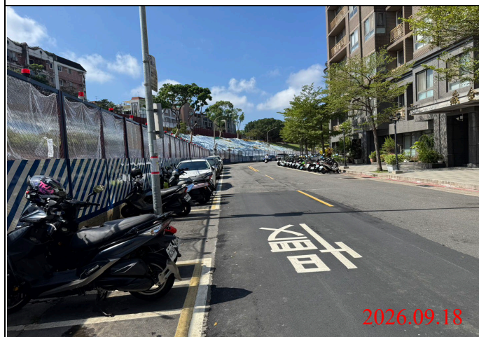
巡查日期地點：115.09.18/ Y33車站 照片說明：路面狀況
