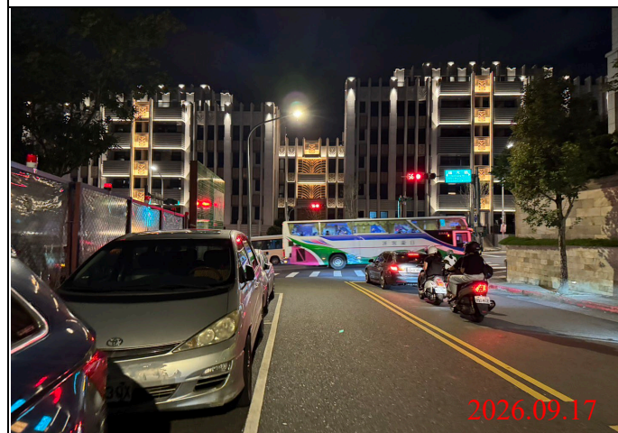
巡查日期地點：115.09.17/ Y33車站 照片說明：夜間路面、路燈及警示燈狀況
