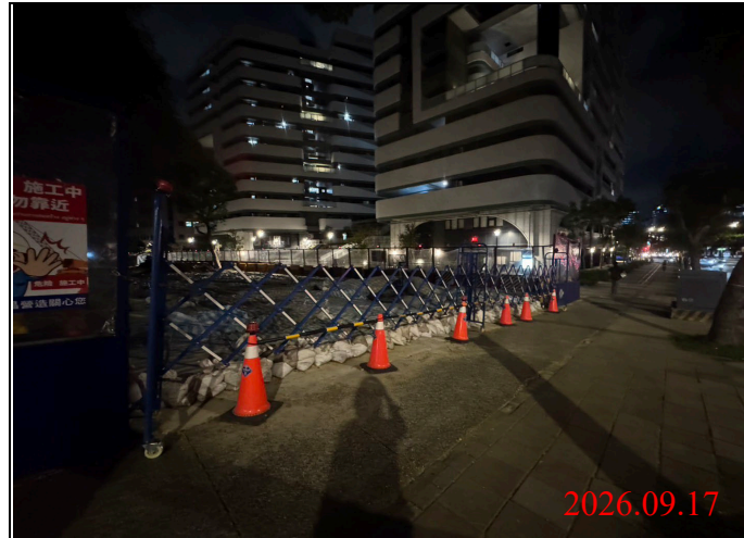
巡查日期地點：115.09.17/ Y33車站 照片說明：出入口大門確實關閉上鎖
