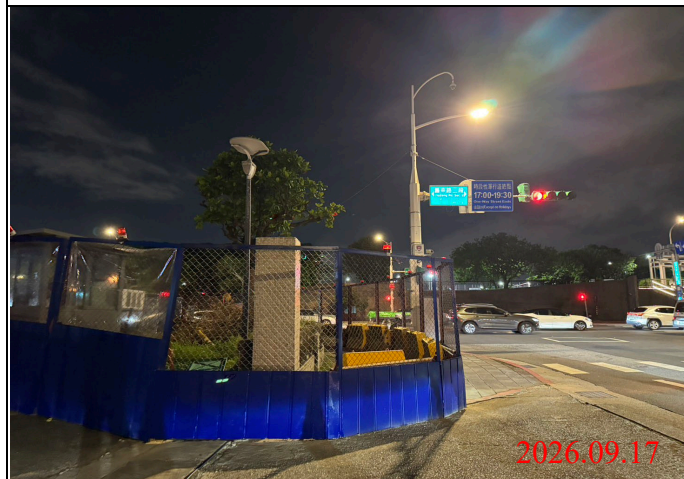
巡查日期地點：115.09.17/ Y34車站 照片說明：夜間路面、路燈及警示燈狀況
