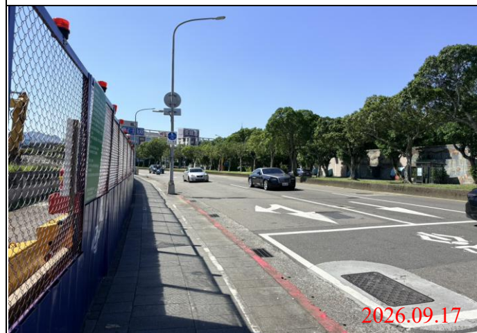
巡查日期地點：115.09.17/ Y34車站 照片說明：路面狀況
