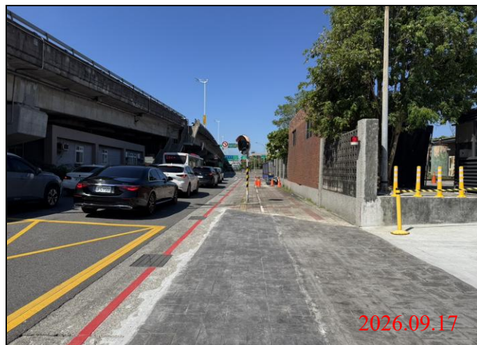
巡查日期地點：115.09.17/ Y34車站 照片說明：路面狀況
