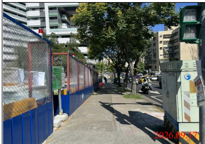
巡查日期地點：115.09.17/ Y33車站 照片說明：路面狀況
