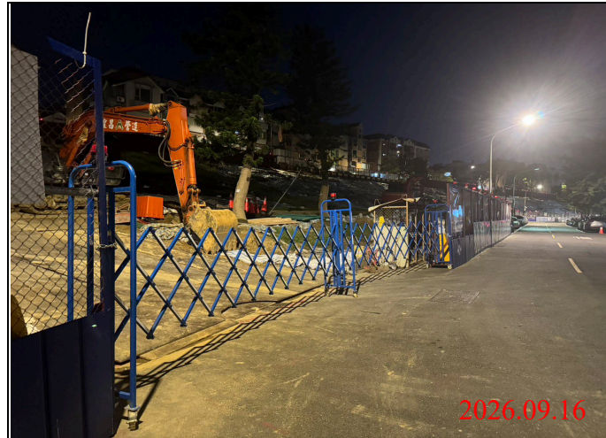
巡查日期地點：115.09.16/ Y33車站 照片說明：出入口大門確實關閉上鎖
