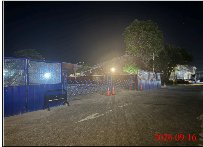
巡查日期地點：115.09.16/ Y34車站 照片說明：出入口大門確實關閉上鎖
