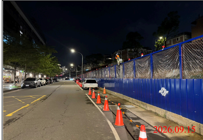
巡查日期地點：115.09.15/ Y33車站 照片說明：夜間路面、路燈及警示燈狀況
