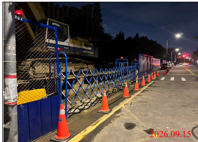
巡查日期地點：115.09.15/ Y33車站 照片說明：出入口大門確實關閉上鎖
