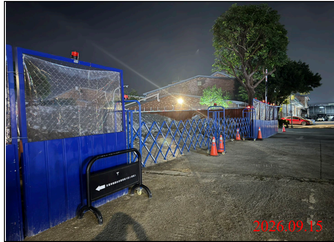
巡查日期地點：115.09.15/ Y34車站 照片說明：出入口大門確實關閉上鎖
