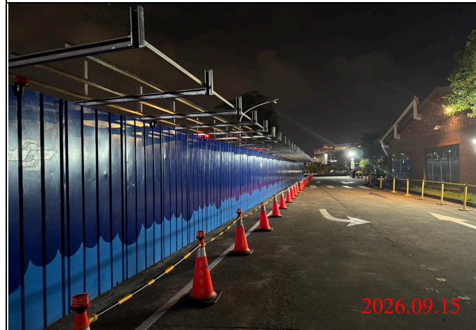
巡查日期地點：115.09.15/ Y34車站 照片說明：夜間路面、路燈及警示燈狀況
