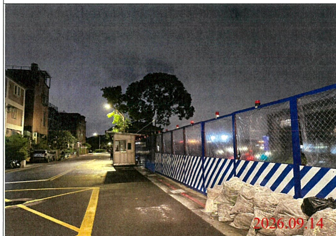
巡查日期地點：115.09.14/ Y33車站 照片說明：夜間路面、路燈及警示燈狀況
