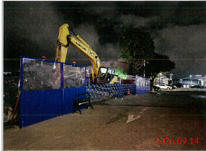
巡查日期地點：115.09.14/ Y34車站 照片說明：出入口大門確實關閉上鎖
