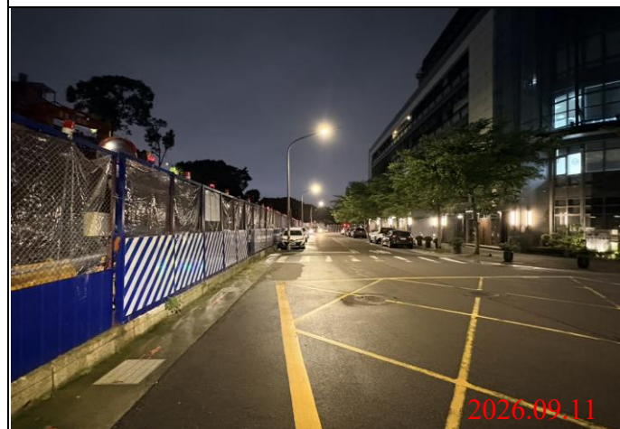
巡查日期地點：115.09.11/ Y33車站 照片說明：夜間路面、路燈及警示燈狀況
