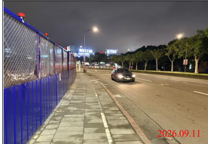
巡查日期地點：115.09.11/ Y34車站 照片說明：夜間路面、路燈及警示燈狀況
