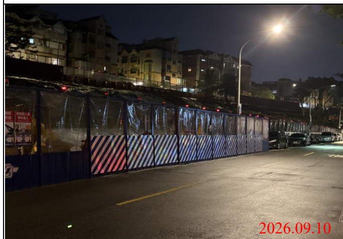
巡查日期地點：115.09.10/ Y33車站 照片說明：夜間路面、路燈及警示燈狀況
