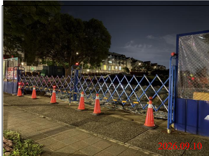
巡查日期地點：115.09.10/ Y33車站 照片說明：出入口大門確實關閉上鎖
