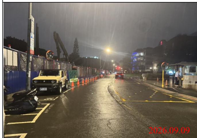
巡查日期地點：115.09.09/ Y33車站 照片說明：夜間路面、路燈及警示燈狀況
