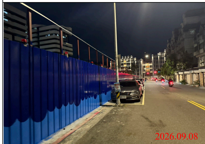
巡查日期地點：115.09.08/ Y33車站 照片說明：夜間路面、路燈及警示燈狀況
