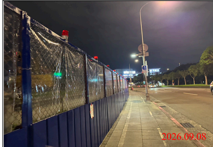
巡查日期地點：115.09.08/ Y34車站 照片說明：夜間路面、路燈及警示燈狀況
