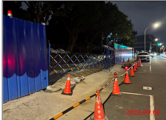
巡查日期地點：115.09.08/ Y33車站 照片說明：出入口大門確實關閉上鎖
