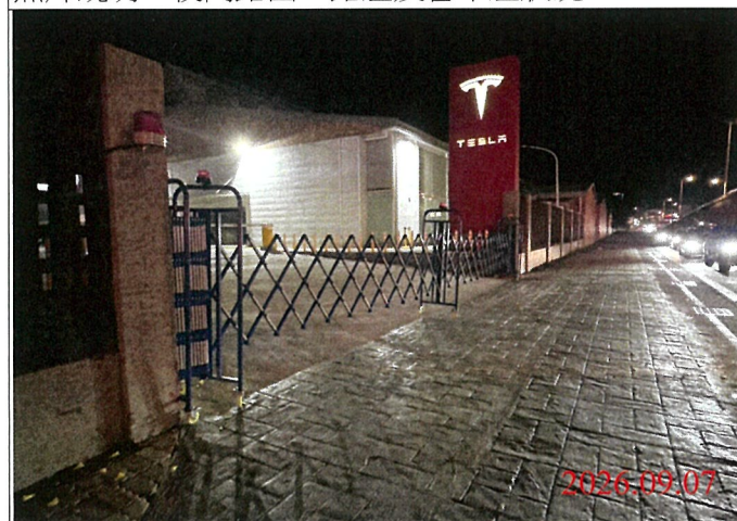
巡查日期地點：115.09.07/ Y34車站 照片說明：出入口大門確實關閉上鎖
