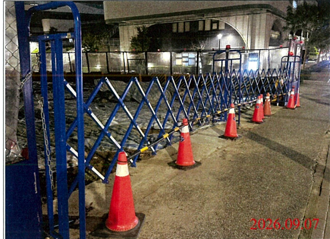
巡查日期地點：115.09.07/ Y33車站 照片說明：出入口大門確實關閉上鎖
