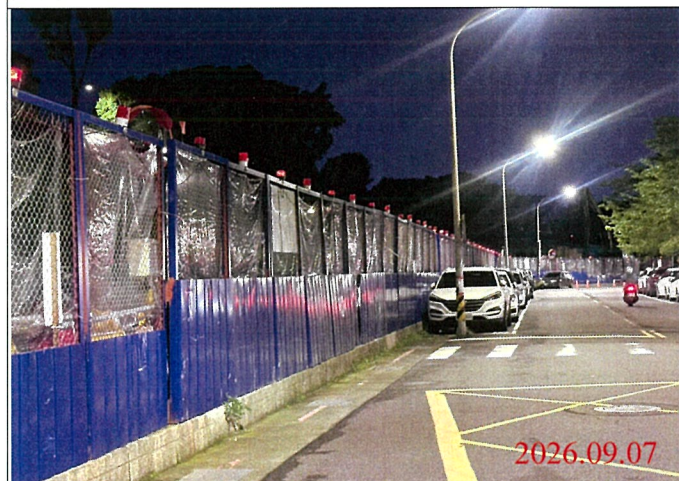
巡查日期地點：115.09.07/ Y33車站 照片說明：夜間路面、路燈及警示燈狀況
