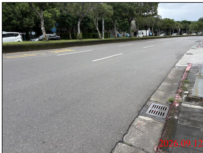
巡查日期地點：115.09.12/ Y34車站 照片說明：路面狀況
