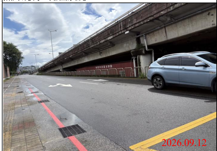
巡查日期地點：115.09.12/ Y34車站 照片說明：路面狀況
