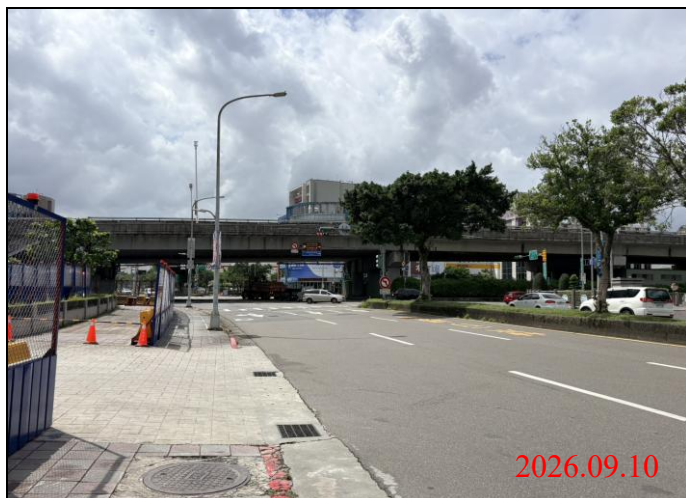
巡查日期地點：115.09.10/ Y34車站 照片說明：路面狀況
