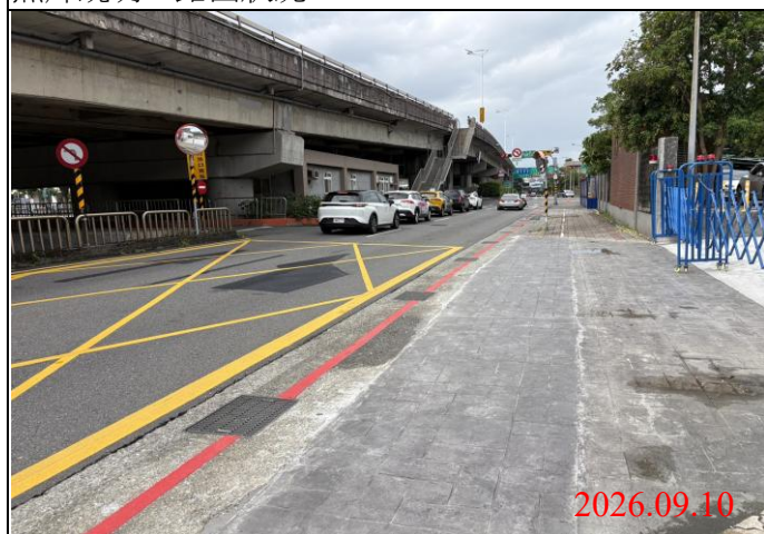
巡查日期地點：115.09.10/ Y34車站 照片說明：路面狀況
