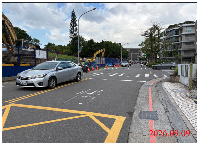
巡查日期地點：115.09.09/ Y33車站 照片說明：路面狀況
