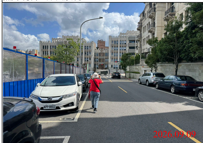
巡查日期地點：115.09.09/ Y33車站 照片說明：路面狀況
