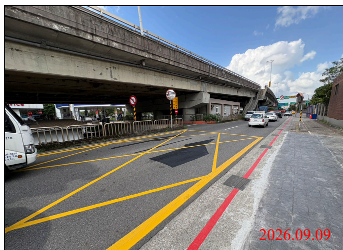
巡查日期地點：115.09.09/ Y34車站 照片說明：路面狀況
