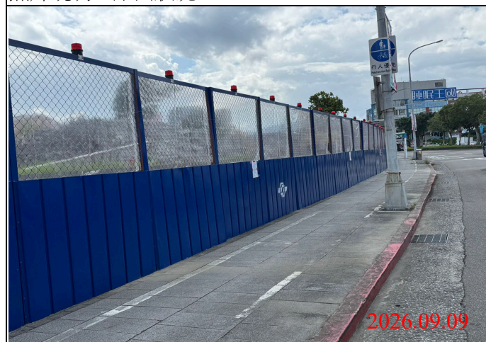
巡查日期地點：115.09.09/ Y34車站 照片說明：路面狀況
